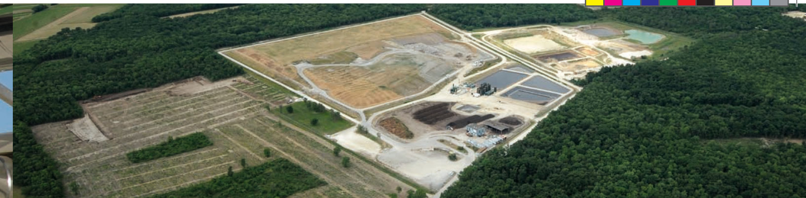
Vue aérienne du site avant travaux (le 24 mai 2011)
